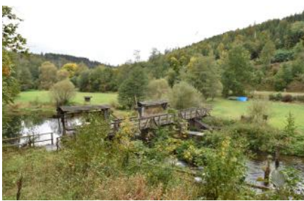
Talau der Nagold bei Altensteig mit der rekonstruierten Monhardter Wasserstube aus der Flößzeit
