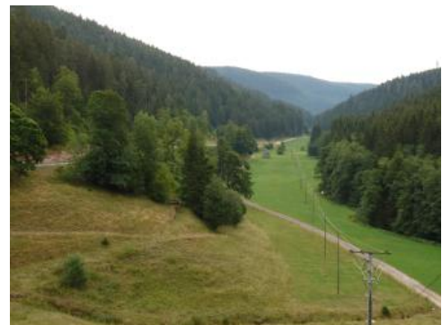
Das Linachtal südlich von Vöhrenbach
